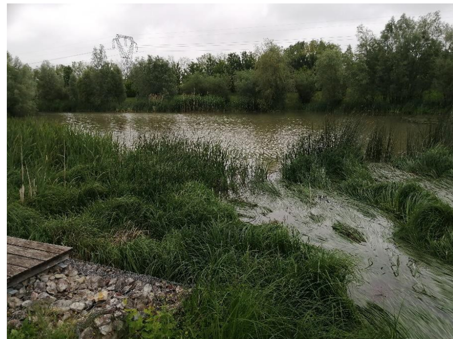
Ouvrage de gestion des eaux pluviales en milieu urbain à Bezannes (51) : régulation et d'épuration des eaux, régulation climatique, support de biodiversité, paysage et éducation à l'environnement (Photo Cerema / L. Chrétien)
